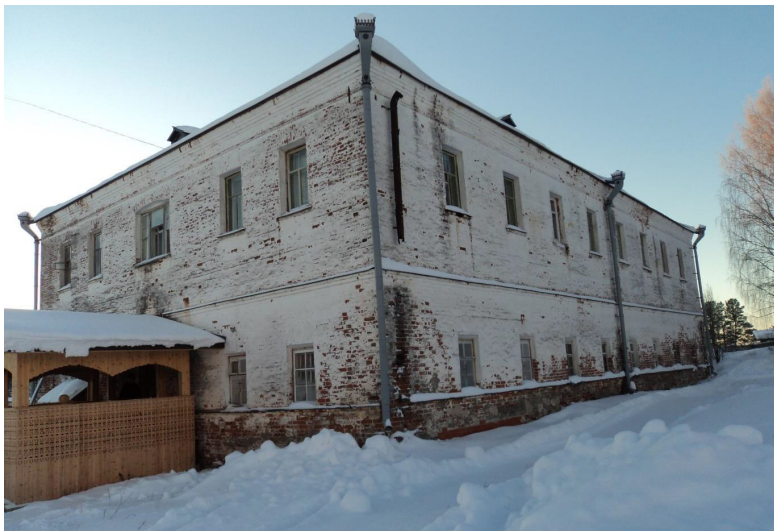
Отремонтированный гостевой корпус.
