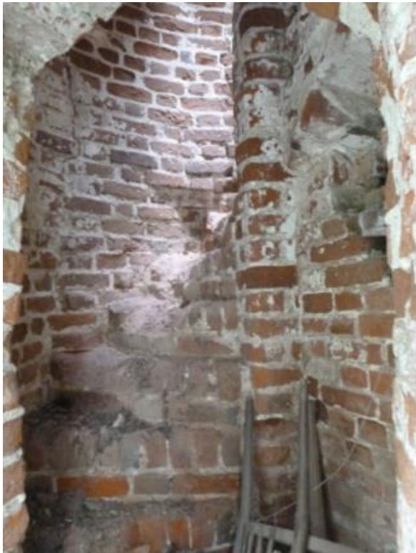
11. Внутростенная винтовая лестница на колокольню
