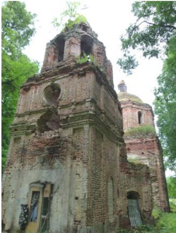
9. Вид на колокольню с юго-западной стороны
