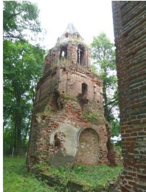
8. Вид на колокольню с юго-восточной стороны
