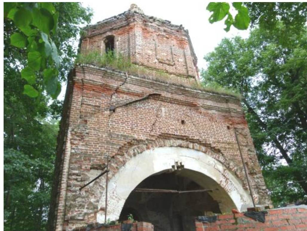
6. Фрагмент восточного фасада
