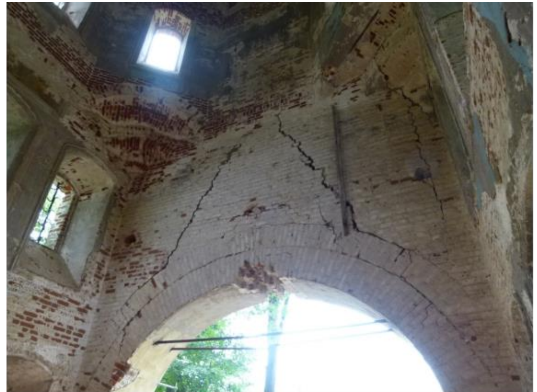
16. Тройные ступенчатые тромпы. Интерьер четверика (помещение Б)
