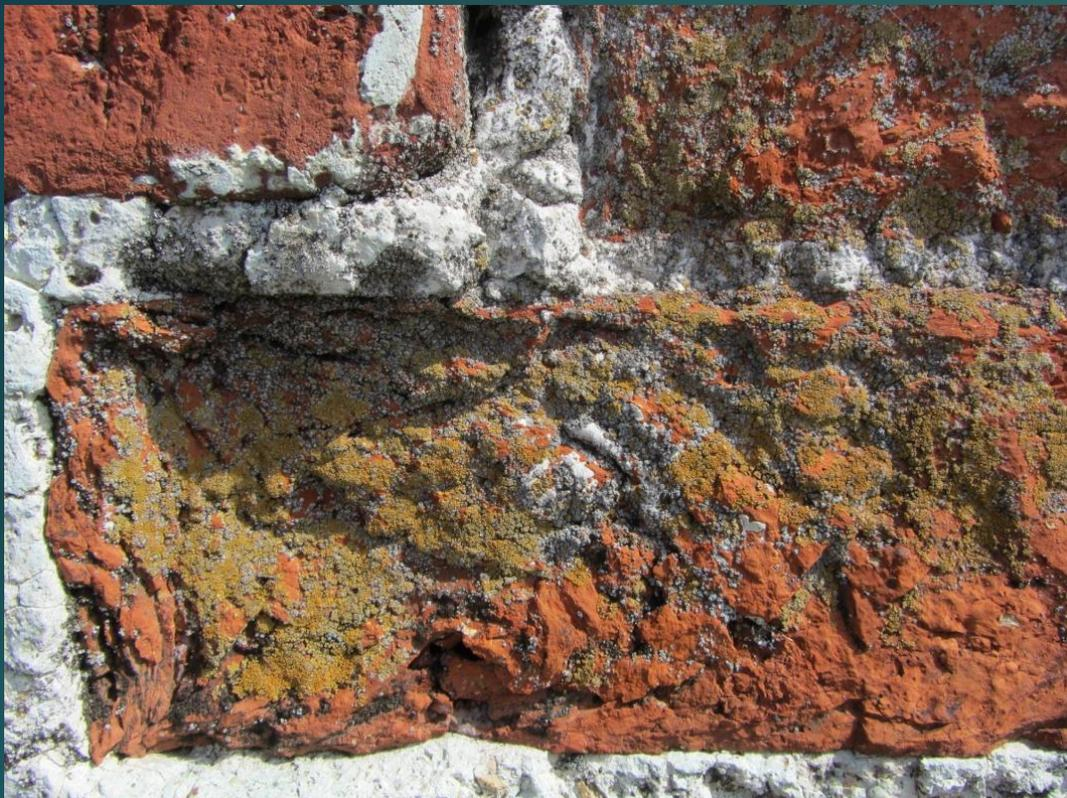
Биодеструкторы ведут к образованию бактерий, которые способствуют превращению сернистого газа и оксида азота в серную и азотную кислоты, что ведет к разрушению материала
